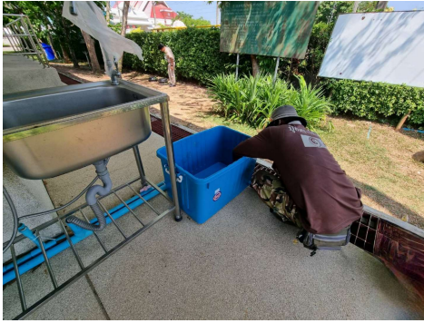
๓. ภาพการดำเนินการติดตั้งบ่อดักไขมันขององค์กรปกครองส่วนท้องถิ่น
