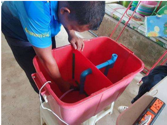
๓. ภาพการดำเนินการติดตั้งบ่อดักไขมันขององค์กรปกครองส่วนท้องถิ่น
